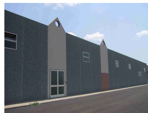
Facciata principale opificio con celle
